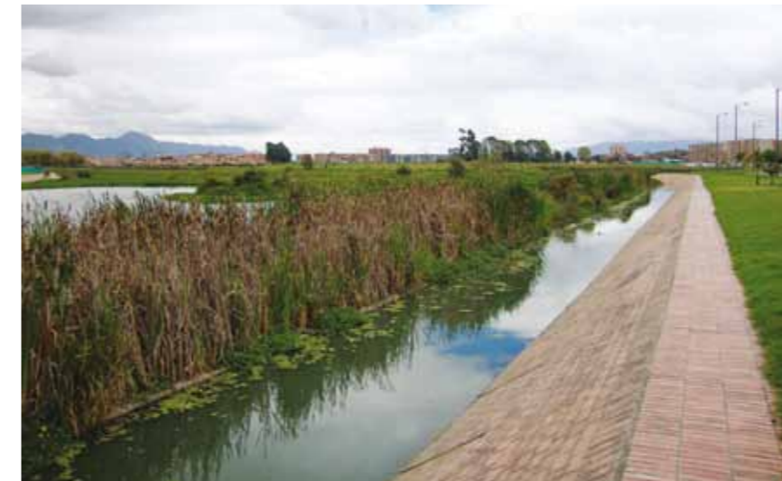
HUMEDAL DE JABOQUE, ENGATIVÁ.
