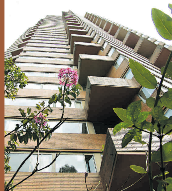
RESIDENCIAS EL PARQUE, TORRE A – FOTO © GUILLERMO ANGULO
